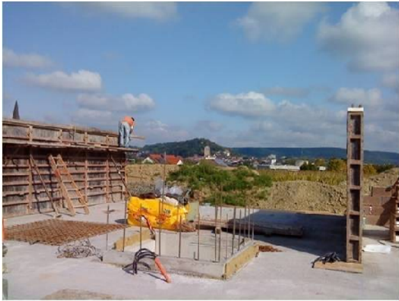
Figura 8 – Canteiro de obra Fonte: Os autores
