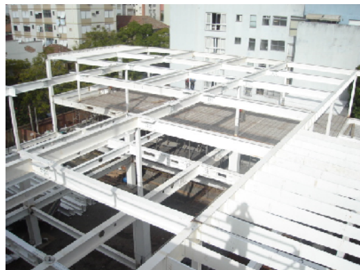
Figura 7 – Planejamento da instalação dos elementos pré-moldados por meio da prototipagem Fonte: CARVALHO, 2008
