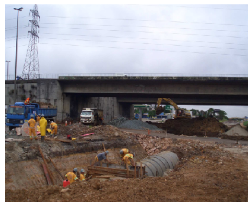
Figura 5 – Canteiro de obra Fonte: Os autores
