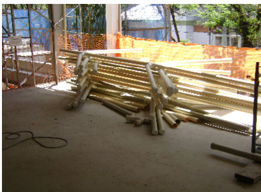
Figura 6 – Montagem de kits de peças hidráulicas fora do ponto de aplicação Fonte: CARVALHO, 2008
