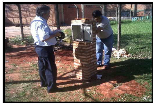
Figura 5 – Instalación de sensores Fuente: Propia
