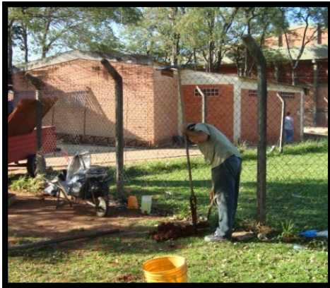
Figura 1 – Perforación de pozo Fuente: Propia
